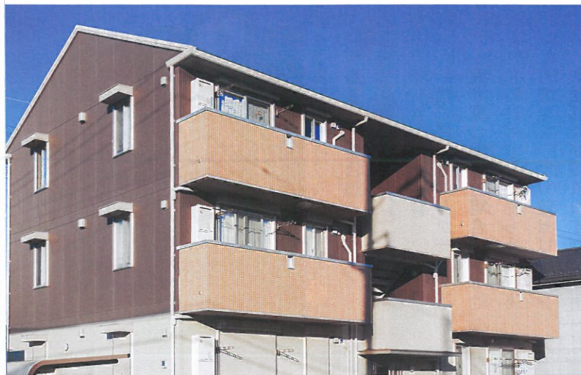
入居者目線になってみると、臭いや小さな汚れ、設備不良・改善点などが見つかることも。管理会社に任せっきりにならないように
